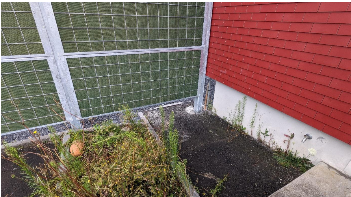
Abbildung 2 - Detail Fundamentierung und Bodenabstand
