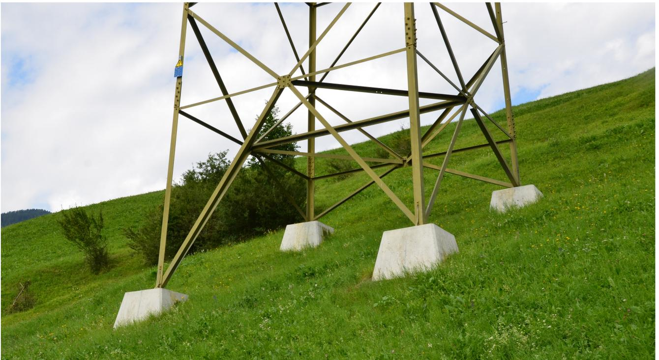
Abbildung 12: Fussbereich Mast mit Betonfundamente und Mastfuss-Fachwerk (Mast Nr. 244 [2]).
