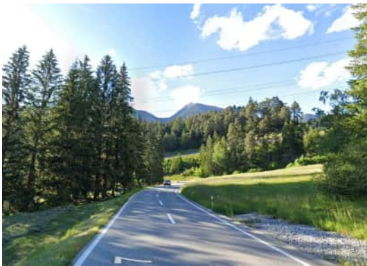
Abb. 2: Einfahrt in Richtung Alvaneu
