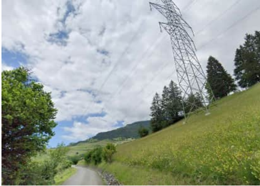
Abb. 6: Einfahrt in Richtung Muldain
