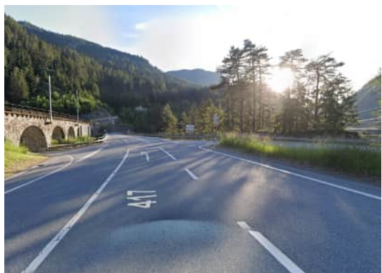
Abb. 82: Einfahrt in Richtung Vaz
