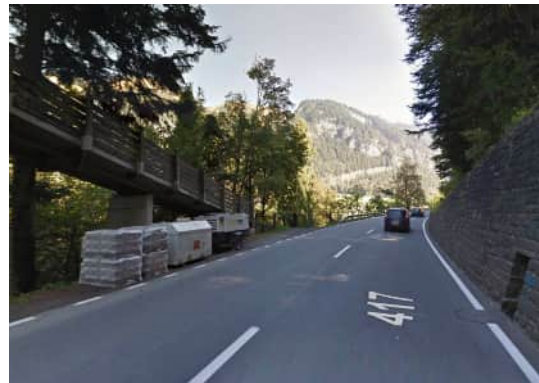
Abb. 77: Einfahrt in Richtung Tiefencastel
