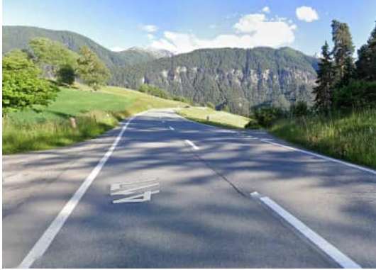
Abb. 23: Einfahrt in Richtung Alvaneu
