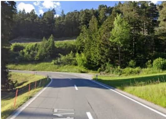
Abb. 26: Einfahrt in Richtung Alvaneu
