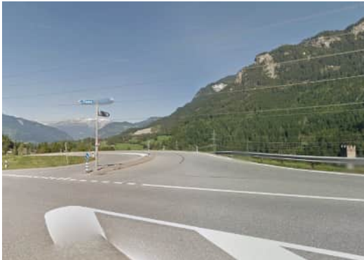
Abb. 74: Einfahrt zu M252-M254 und M256-257
