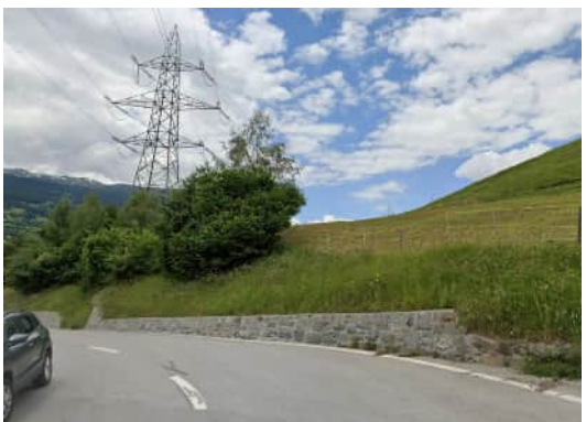
Abb. 48: Einfahrt zu M229
