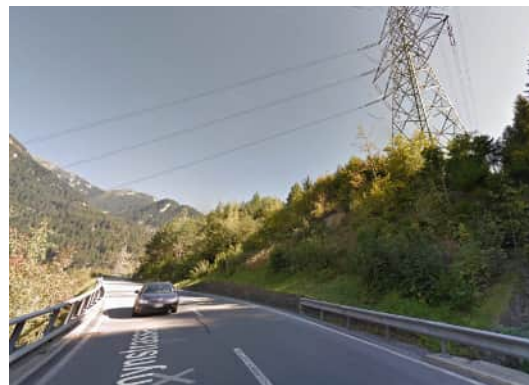
Abb. 80: Einfahrt in Richtung Tiefencastel
