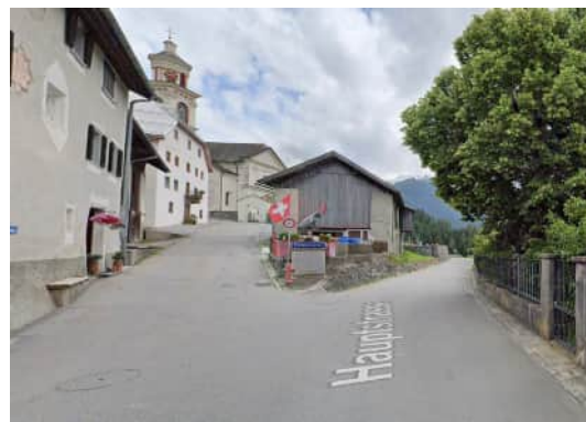
Abb. 61: Einfahrt in Richtung Tiefencastel
