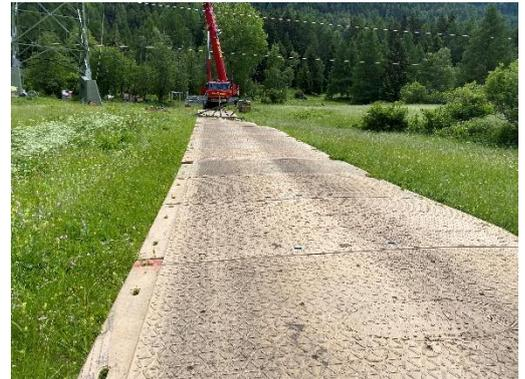
Abbildung 15: Beispiel Baggerplatten
