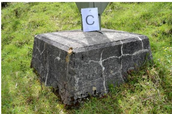
Abbildung 11: Mast 1360x203 Eckstiel C
