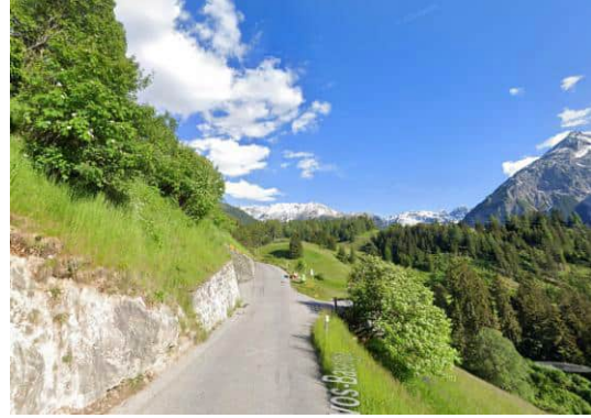
Abb. 80: Einfahrt in Richtung Latsch
