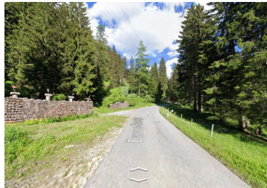
Abb. 77: Einfahrt in Richtung Latsch
