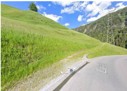
Abb. 65: Einfahrt zu M181
