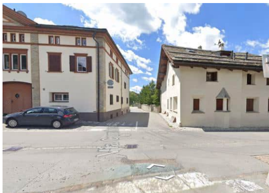
Abb. 2: Einfahrt zu Bobinenplatz und M127
