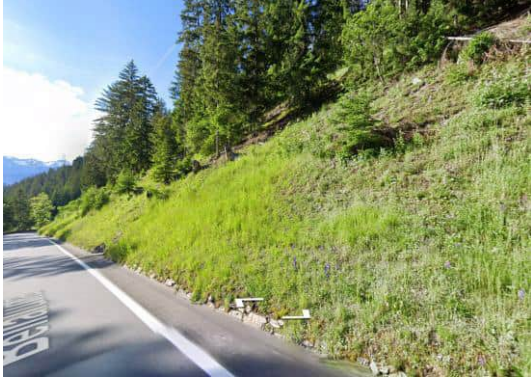
Abb. 86: Zugang zu M189 in Richtung Filisur
