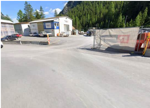
Abb. 50: Einfahrt zu M171
