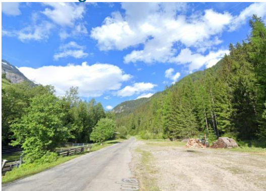
Abb. 10: Einfahrt in Richtung Latsch
