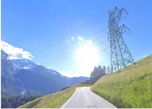
Abb. 12: Einfahrt in Richtung Latsch
