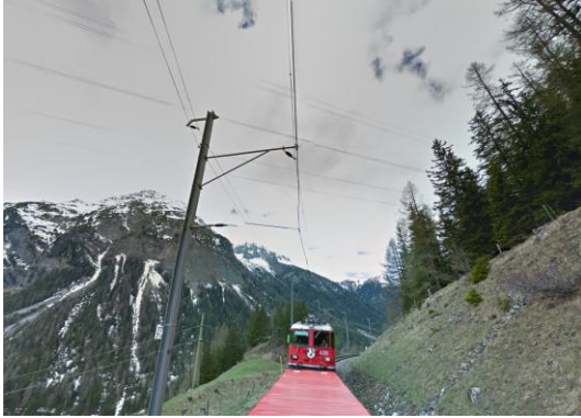
Abb. 5: Einfahrt in Richtung Filisur
