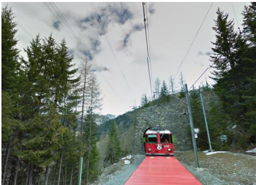
Abb. 3: Einfahrt in Richtung Filisur
