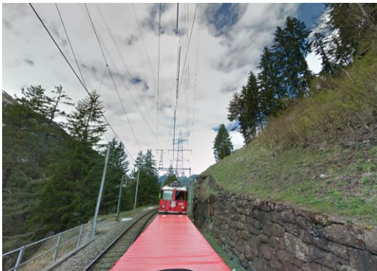
Abb. 9: Einfahrt in Richtung Filisur
