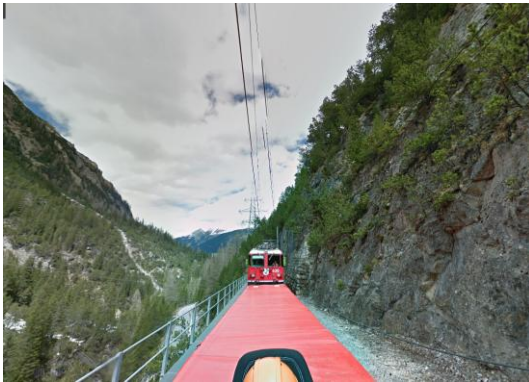
Abb.: Einfahrt in Richtung Filisur
